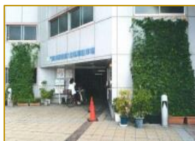
門真市駅南自転車駐車場
